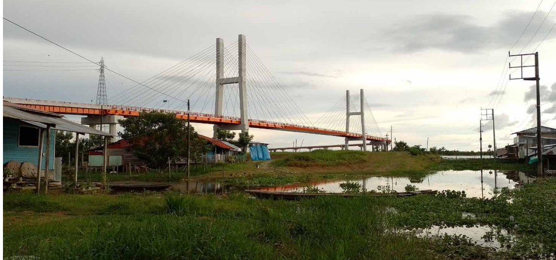
Vista del puente Nanay, que forma parte del Tramo 1 del proyecto vial Bellavista-Mazán, único construido al momento. Foto: Chad Boy.
