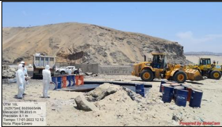
Fotografía N° 12: Vista de acciones de limpieza del área impactada.
