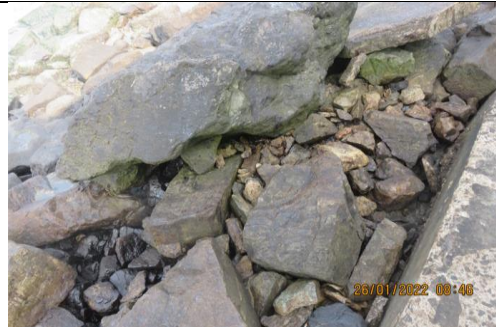
Se observa resto de hidrocarburos impregnados en la roca de la orilla en las coordenadas UTM WGS84 260755E, 8696798N.
